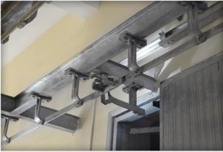
▲ SOĞUK HAVA DEPOSU GİRİŞİ
